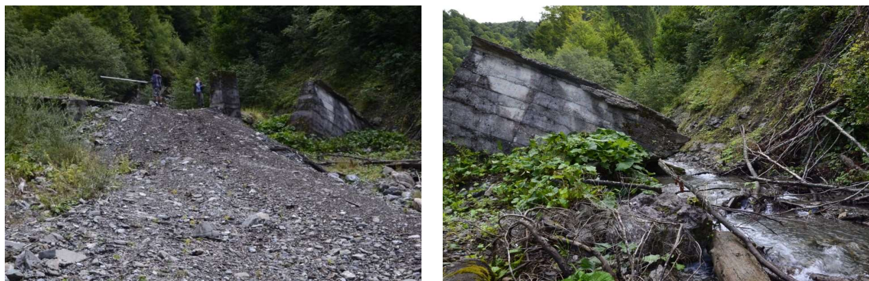
Fig. 5.22. Lucrarea 90 BCF 2.0 - Pârâul Vinderel
