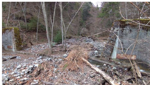
Fig. 5.9. Devierea cursului de apă din cauza colmatarii radierului
