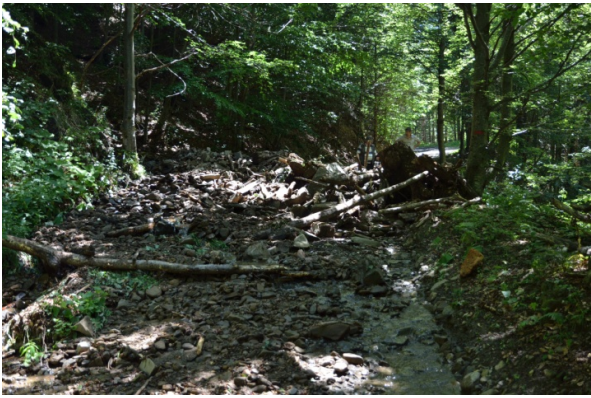
Fig. 1.1. Transport torențial debușat pe drumul forestier în urma blocării unui podeț de evacuare (Davidescu, 2018)
