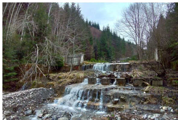
Fig. 5.38. Desprindere înregistrată la pintenul terminal Lucrarea 2 B 3,0 – Pârâul Nanului (Foto: Mihalache, 2019)
