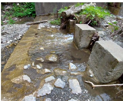
Fig. 5.37. Eroziunea radierului la lucrarea 11 B 2,0 Pârâul Tigăi (Foto: Mihalache, 2020)
