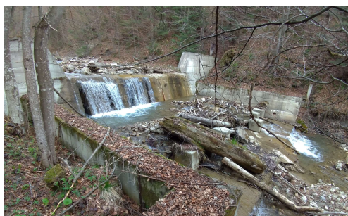
Fig. 5.40. Colmatarea radierului Lucrarea 11 B 2,0 – Pârâul Tesla (Foto: Mihalache, 2019)
