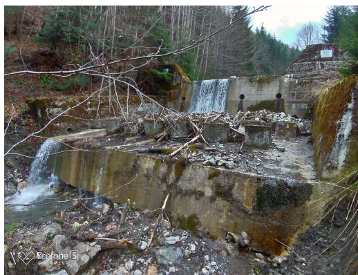
Fig. 5.35. Afuiere a radierului
