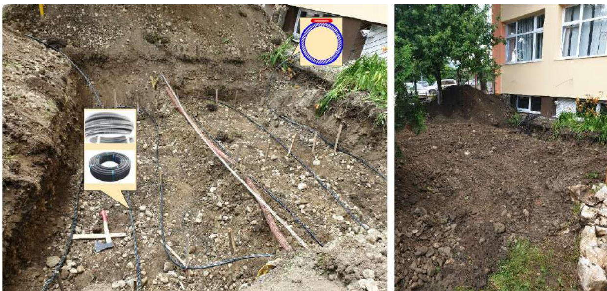
Fig. 5.2. – Fotografii din timpul execuției schimbătorului de căldură geotermic orizontal
