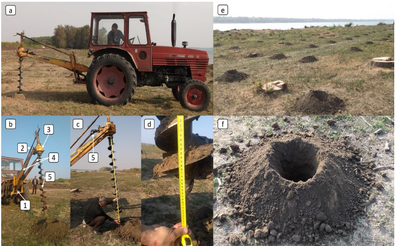
Figura 7. Descrierea de ansamblu a tractorului, echipamentului de săpare, precum și a modalității și schemei de săpare
