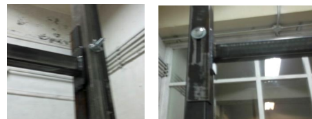
Fig.4.58. Fixare și reglare grindă inferioară
