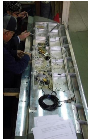
Fig. 3.2 Instalarea și verificarea scanivalvelor mecanice în aripă
