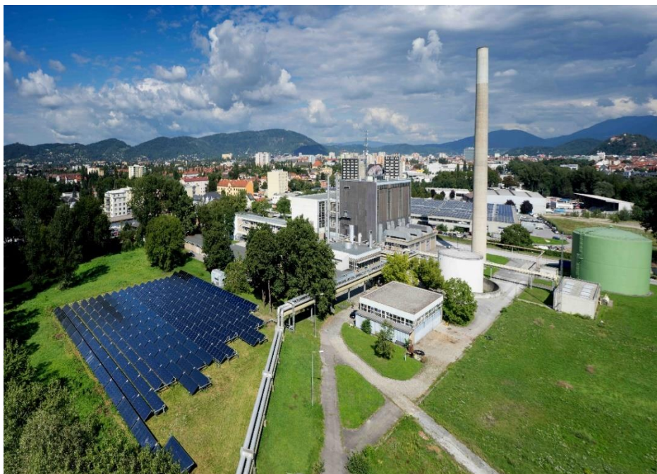
Figura 1.19. Sistemul hibrid solar-biomasă Crailsheim, Germania [67]
