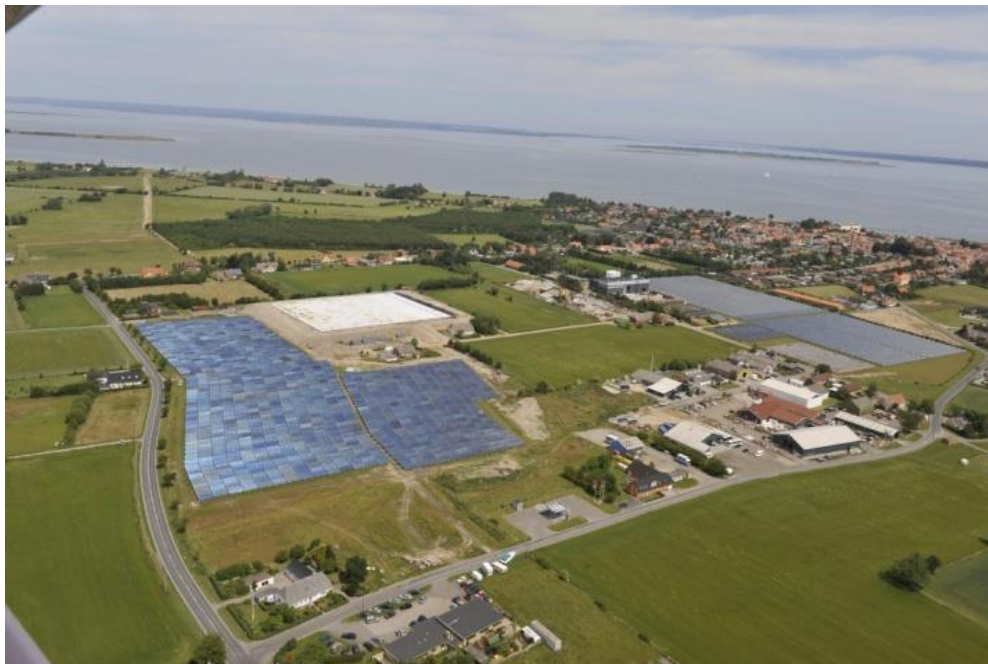
Figura 1.9. Sistemul hibrid solar-biomasă din Marstal, Danemarca [63]
