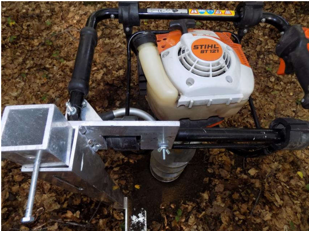
Fig. 5.2 Montarea sistemului de siguranță pe cadru Fig. 5.2 Installing the worker safety system on the drill
