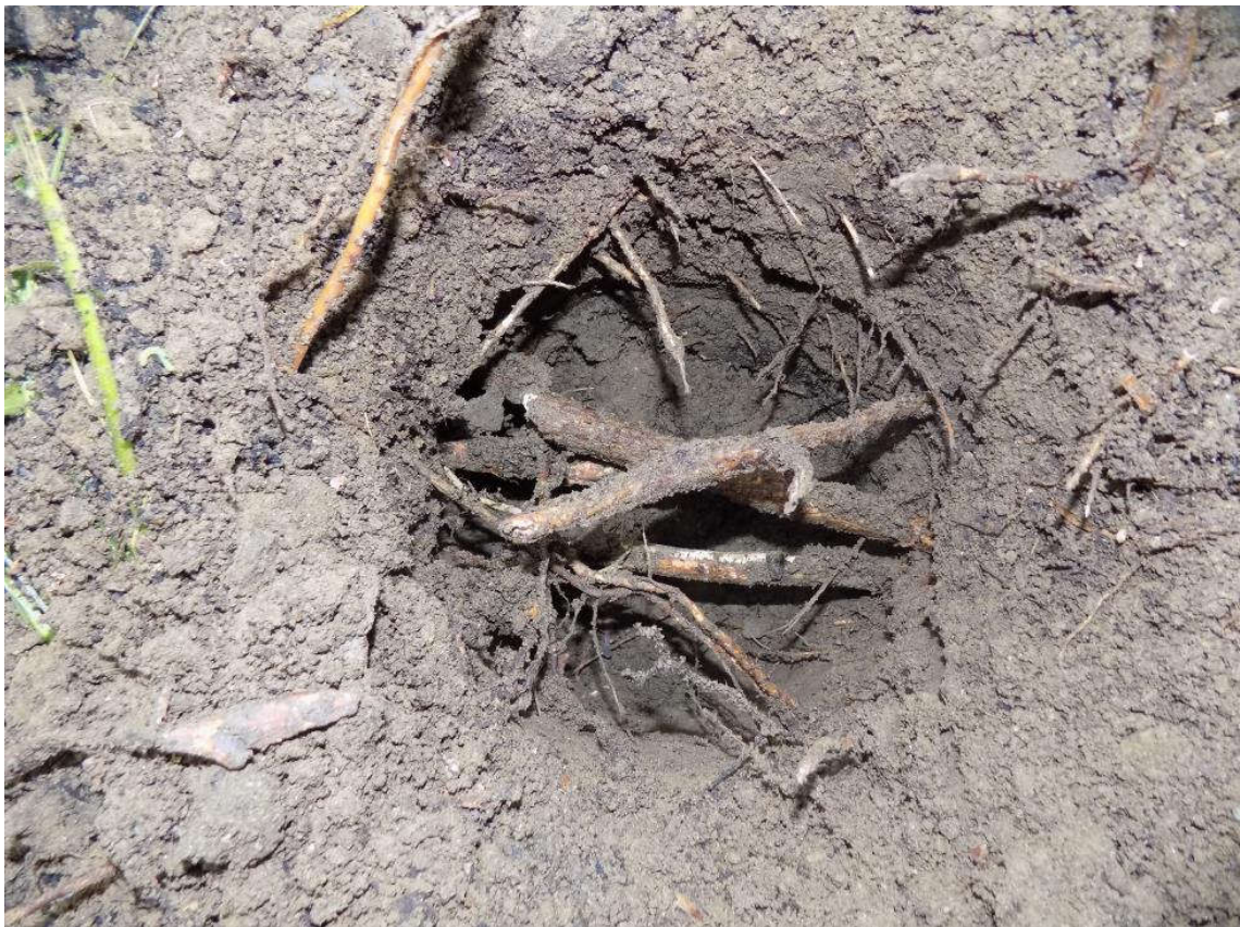
Fig. 5.14 Imposibilitatea forării gropii datorită unui număr foarte mare de rădăcini Fig. 5.14 Impossibility of hole execution due to large number of roots
