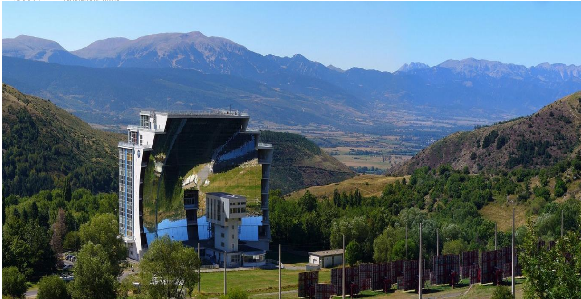
Fig. 2.2 Cuptorul solar MWSF (Megawatt Solar Furnace) Centrul Național de Cercetare Științifică "Procedee, Materiale și Energie Solară" (CNRS -PROMES) din localitatea Font-Romeu-Odeillo (Franța) [124].
