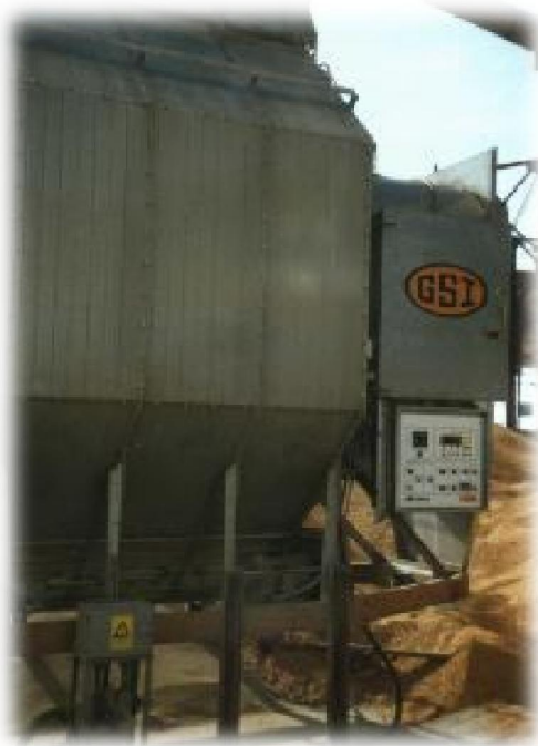
Panoul de comandă a instalației de uscare folosită la cercetarea experimentală
