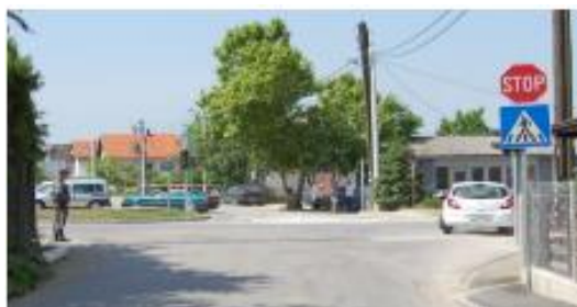
Fig. 1.7 Exemplu de tronson de drum "nesigur", în care este obturată vizibilitatea semaforului.
