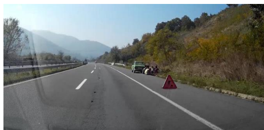
Fig. 1.9 Exemplu de tronson de drum "nesigur", din perspectiva lucrărilor de drum executate.
