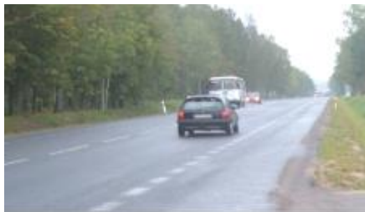
Fig. 1.2 Exemplu de tronson de drum cu 2 benzi de circulație, cu lățimea mare a acostamentelor.
