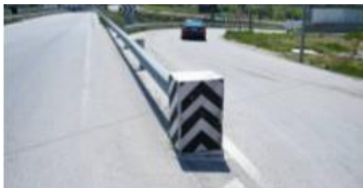
Fig. 1.8 Exemplu de tronson de drum "nesigur", pe care nu este amplasat atenuator la începutul dispozitivului pasiv de siguranța circulației.
